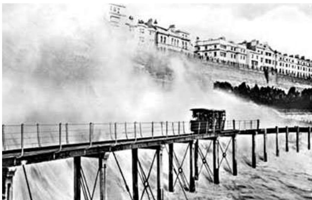
Train affrontant une mer démontée sur le viaduc en bois à l'est de Banjo Grove (carte postale ancienne vers 1890)
