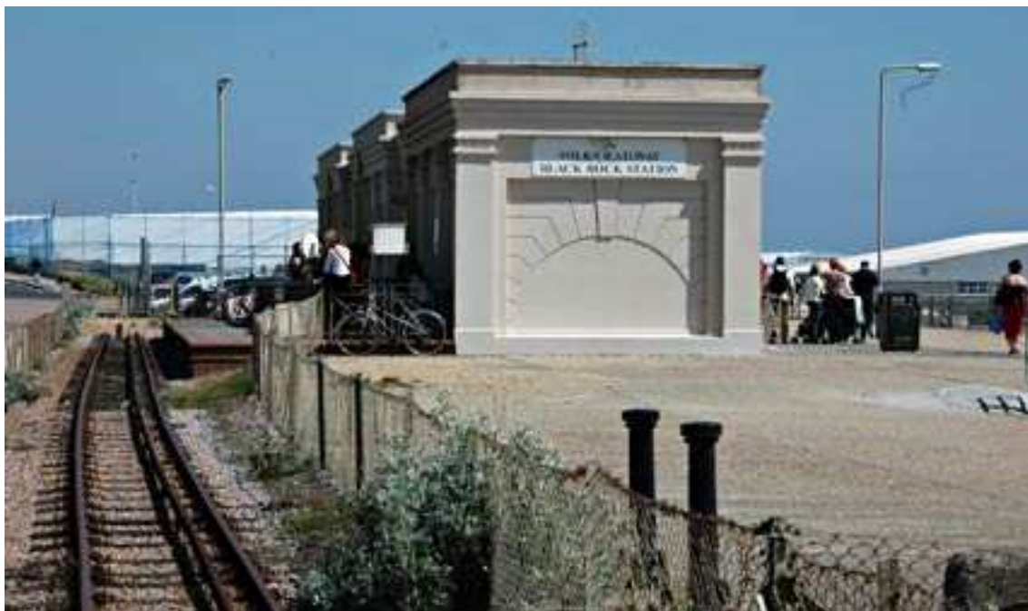
Le terminus démesuré (et d'aspect plutôt sévère) de Black Rock. D'un style néoclassique, la gare à quai unique possède un petit guichet de vente et des toilettes. Le reste du bâtiment abrite une station de pompage.
