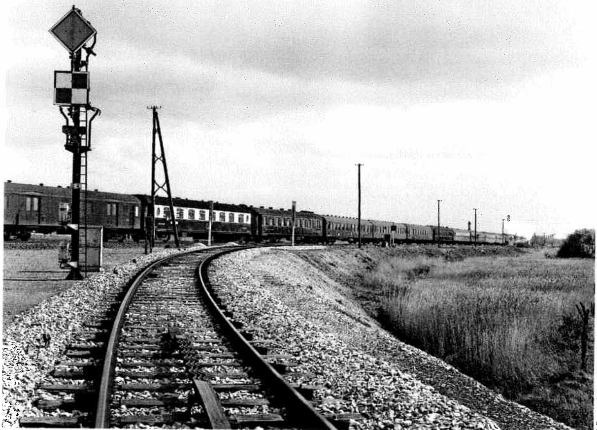
Signaux carrés et avertissements fermés de sortie de l'embranchement au passage d'un train Calais-Maritime - Paris filant vers Amiens (Le Touquet, 1967).
